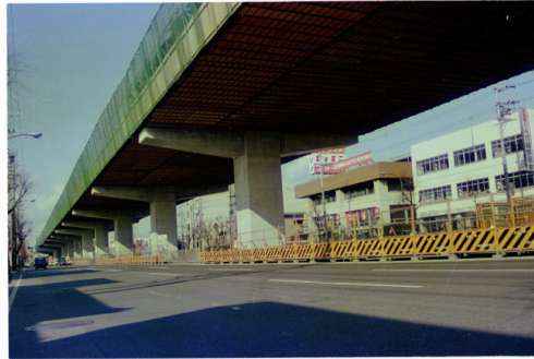
名古屋高速道路 5号万場線 万場二丁目
